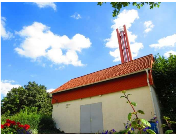
Erweiterung der Stromerzeugung durch 2. BHKW und Einsatz von Biogas im Heizhaus Niederorschel
