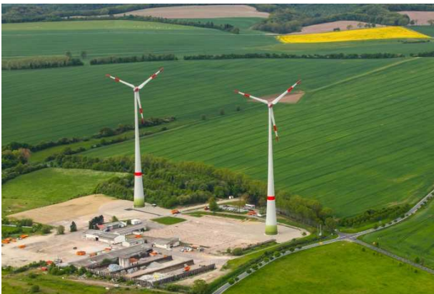
Inbetriebnahme Windpark Dingelstädt
