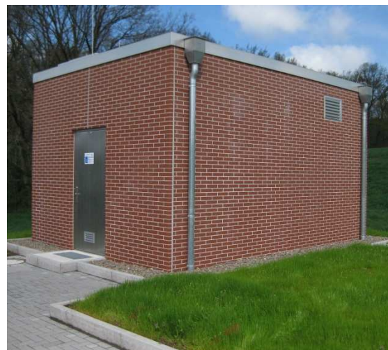
Ersatzneubau Bohrbrunnen, Heilbad Heiligenstadt OT Rengelrode
