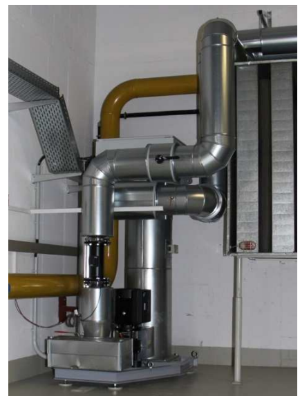
Errichtung einer Power-to-Heat Anlage im Heizhaus Sperberwiese in Heilbad Heiligenstadt
