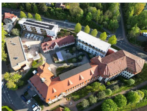
Erweiterung der Wärme- und Stromversorgung im Altenpflegeheim Heiliger Geist in Heilbad Heiligenstadt
