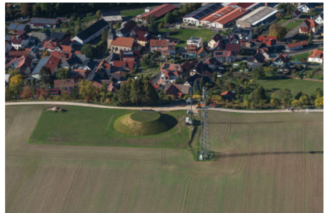
Fertigstellung des neuen Hochbehälters in Kalteneber im Oktober 2022
