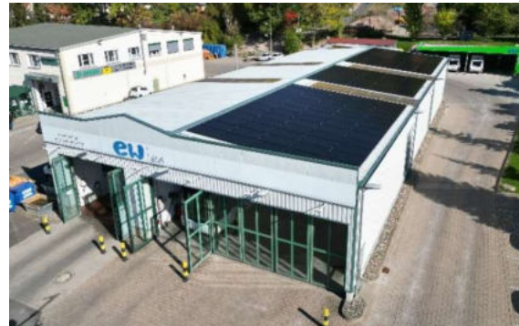
Errichtung einer Photovoltaikanlage auf dem Betriebshof in Heilbad Heiligenstadt
