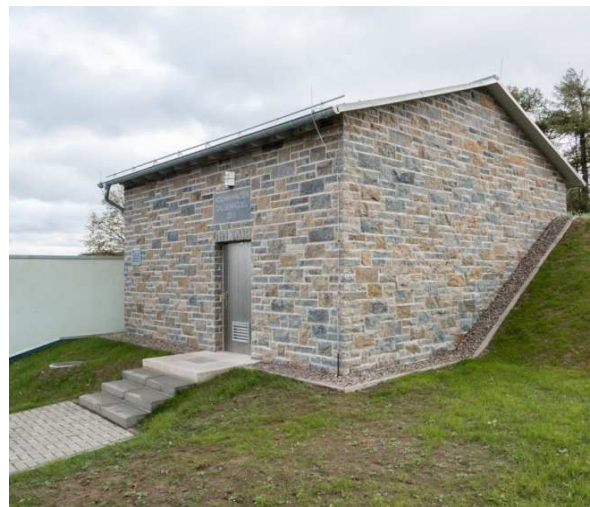
Ersatzneubau Hochbehälter Galgenhügel, Heilbad Heiligenstadt
