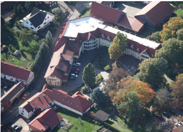
Errichtung einer hocheffizienten Energiezentrale im Altenpflegeheim „Karlshof“ in Birkenfelde
