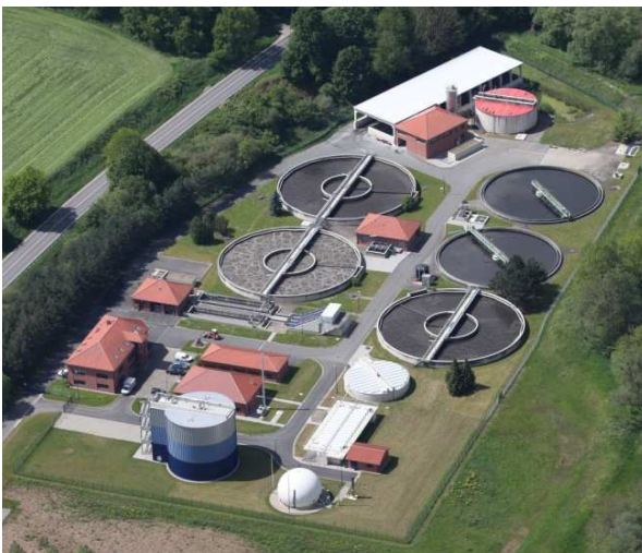
Erweiterung (auf 80.000 Einwohnwe) und energieeffiziente Optimierung der Kläranlage Leinetal
