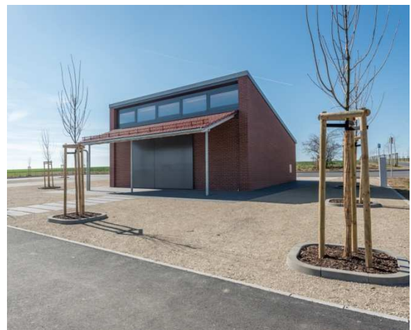
Neubau „Pilgerinformation Papstbesuch 2011“ in Eitzelsbach
