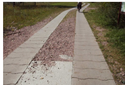
Verzahnte Platten als gute Fahrspurvariante
