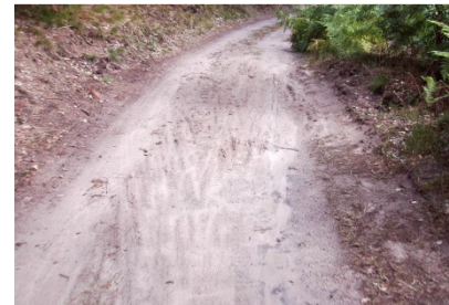
Sehr problematisch: aufgeweichte Sandoberfläche mit tiefen Fahrspuren
