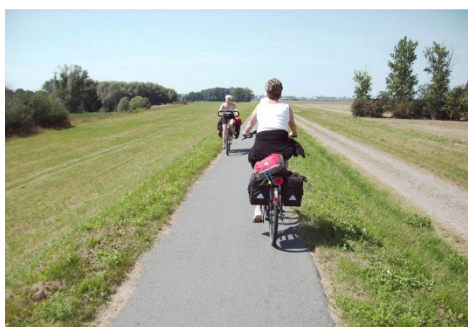
Bei zu eng bemessenen Radwegen führt der Begegnungsfall häufig zu Verunsicherungen und Unfällen.
