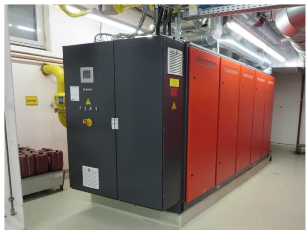
Erneuerung BHKW im Vitalpark in Heilbad Heiligenstadt
