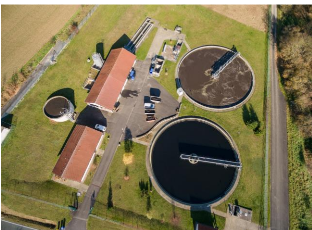
Erweiterung Kläranlage Horsmar
