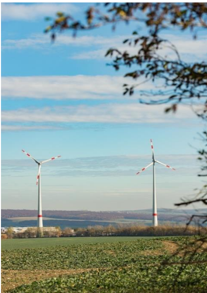
Betrieb Windpark Dingelstädt
