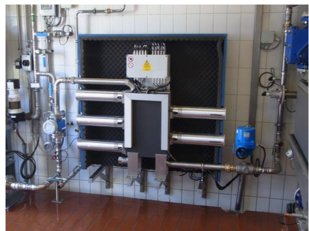
Installation einer Desintegrationsanlage in die Kläranlage Leinetal
