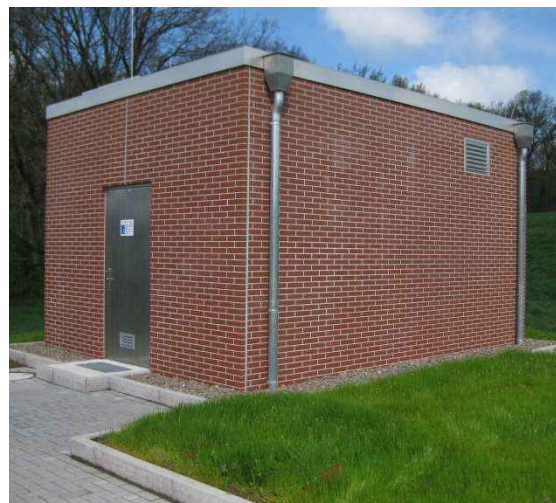
Ersatzneubau Bohrbrunnen, Heilbad Heiligenstadt OT Rengelrode
