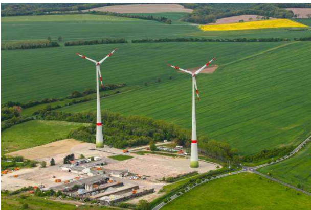
Inbetriebnahme Windpark Dingelstädt
