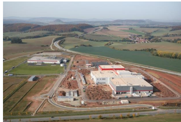
Anbindung des Gewerbegebiets an der A38 an die L1005 im Zusammenhang mit der Ansiedlung des Unternehmens Kaufland Fleischwaren
