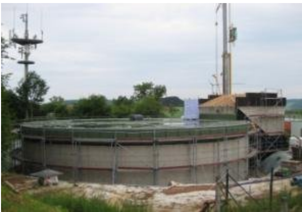
Ersatzneubau Hochbehälter „Galgenhügel“ in Heilbad Heiligenstadt
