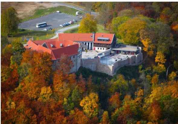
Erdgas- und abwassertechnische Erschließung der Burg Scharfenstein
