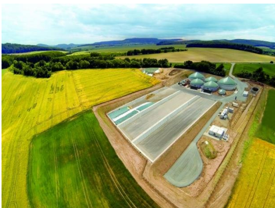
Errichtung einer Bioerzeugung- u. -aufbereitungsanlage bei Weißenborn-Lüderode
