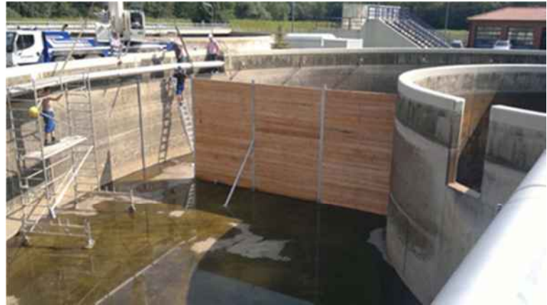
Energieeffiziente Optimierung der Kläranlage Leinetal: Erneuerung des Belüftungssystems in den 3 Belebungsbecken
