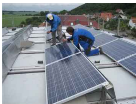
Errichtung einer Photovoltaikanlage auf dem Dach der Grundschule in Brehme
