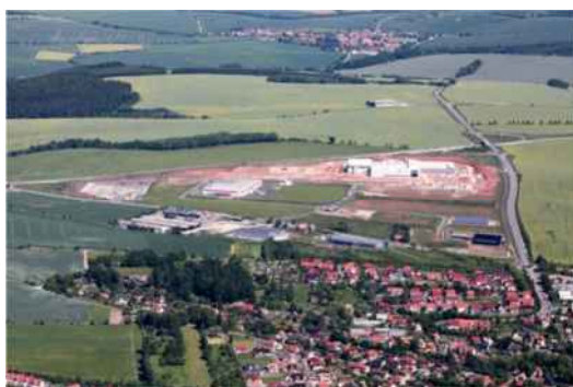
Erschließung des Gewerbegebietes an der A 38
