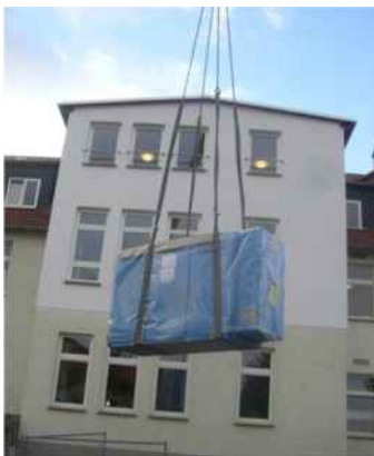
Einbringung BHKW – Altenpflegeheim „St. Josef“ in Breitenworbis
