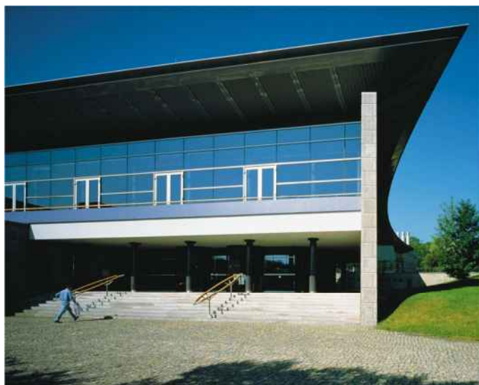
Eingangsbereich E.ON Mitte AG
