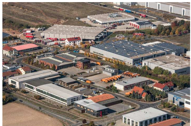
Umbau des Betriebsgebäudes in Leinefelde
