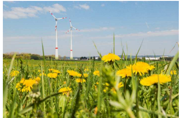
Windkraftanlagen Gewerbegebiet „Auf dem Übel“
