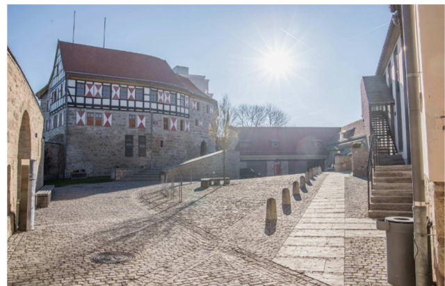
Burg Scharfenstein wird künftig über eine moderne Energiezentrale mit Strom und Wärme versorgt.
