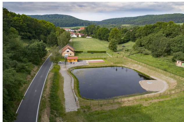
Fertiggestellte Kläranlage Birkenfelde
