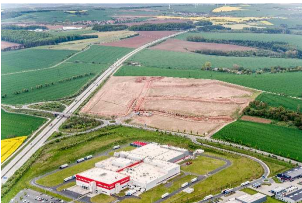
Erschließung des Gewerbegebietes „An der A38 – Ost“
