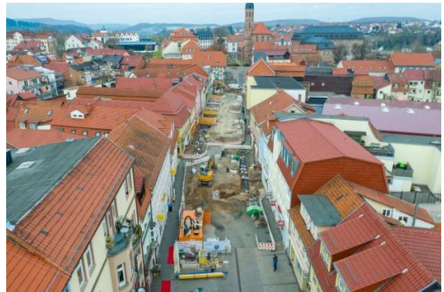
Erneuerung der Fernwärmetrasse in der Wilhelmstraße Heilbad Heiligenstadt
