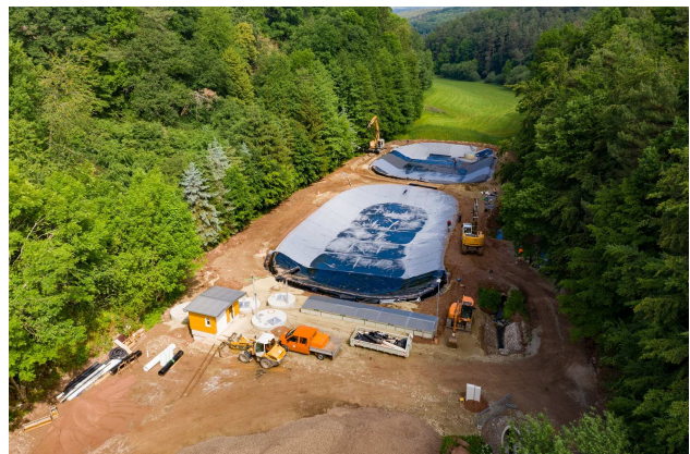
Neubau der Kläranlage in Thalwenden
