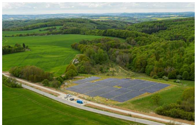
Bau der Photovoltaikanlage Mönchtal (Deponie Brehme)
