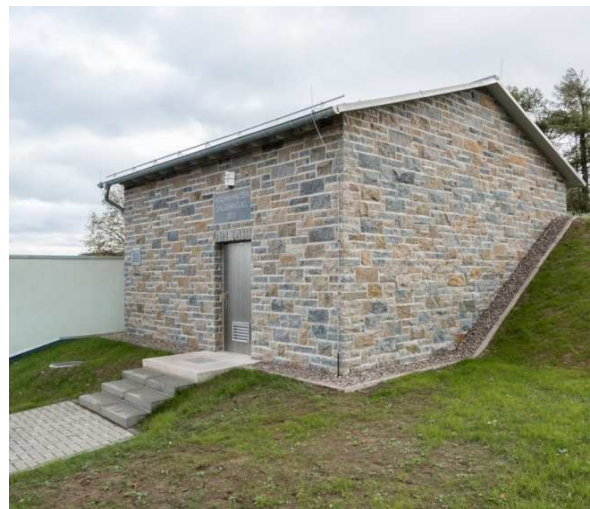
Ersatzneubau Hochbehälter Galgenhügel, Heilbad Heiligenstadt
