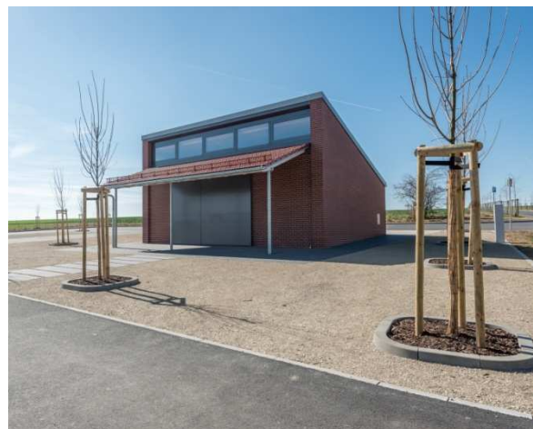
Neubau „Pilgerinformation Papstbesuch 2011“ in Eitzelsbach
