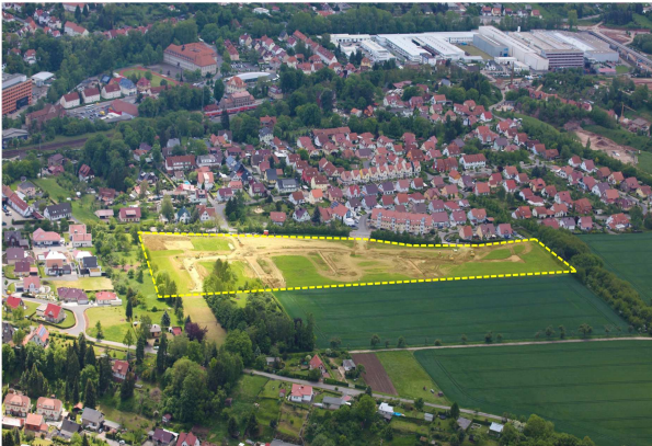
Erschließung des Wohnbaugebietes „Auf dem Hohen Rott – Teil 3“ in Heilbad Heiligenstadt
