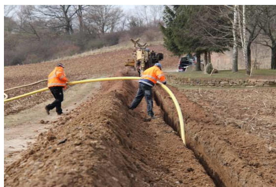
Erschließung Birkenfelde in der offenen Verlegung und im Spülbohrverfahren
