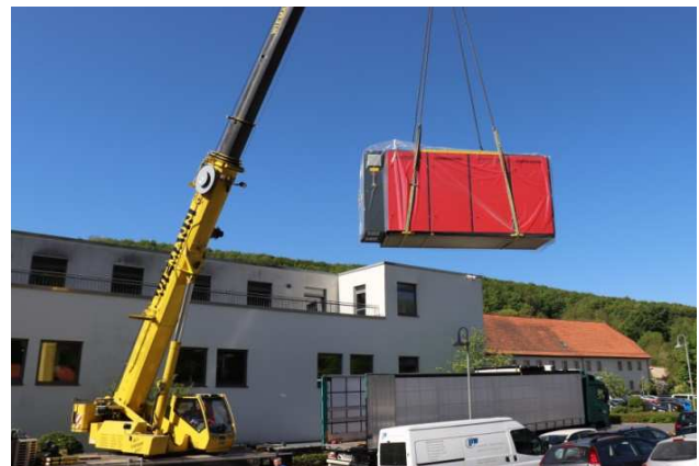
Errichtung eines Blockheizkraftwerks Eichsfeldklinikum gGmbH – Standort Reifenstein
