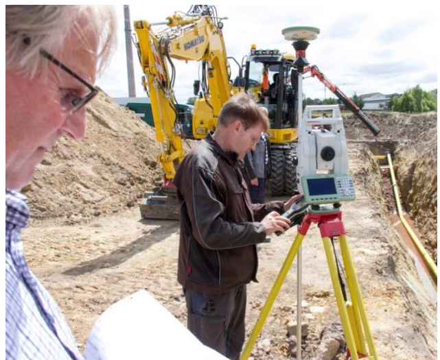
Umlegung der Erdgaszuleitung Kallmerode im Zuge des Neubaus der Ortsumgehung B 247n
