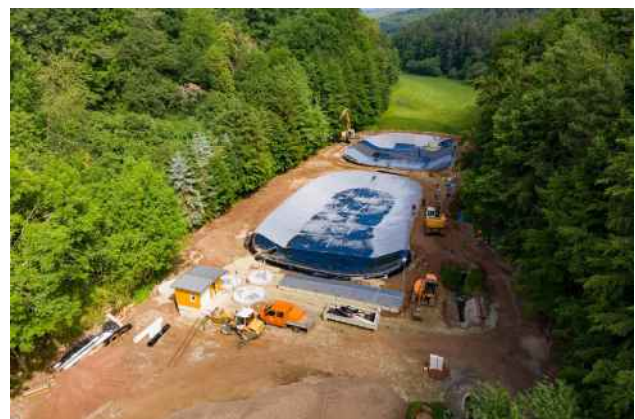
Neubau der Kläranlage in Thalwenden
