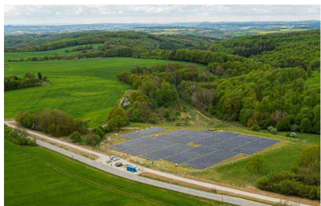
Bau der Photovoltaikanlage Mönchtal (Deponie Brehme)
