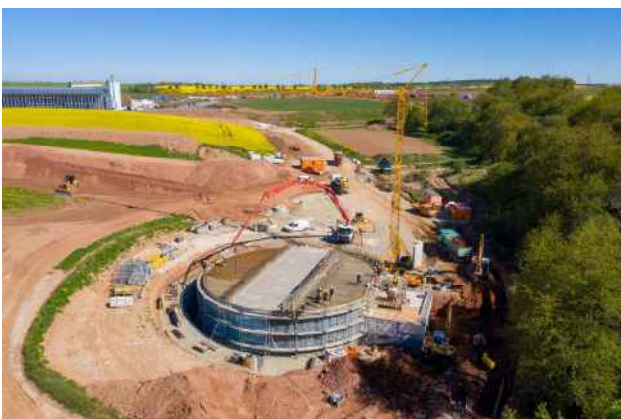
Errichtung des Hochbehälters im Gewerbegebiet „An der A38 – Ost“ in Heilbad Heiligenstadt
