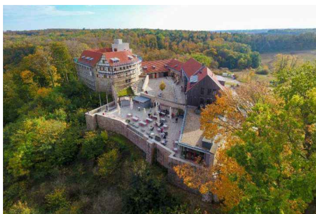
Errichtung BHKW und Erweiterung der Heizungsanlage Burg Scharfenstein
