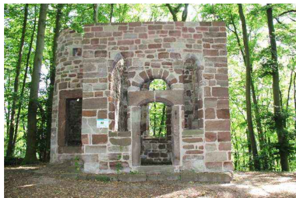
Sanierung der Burgkapelle auf dem Rusteberg - Unterstützung durch LEADER-Fördermittel in 2019
