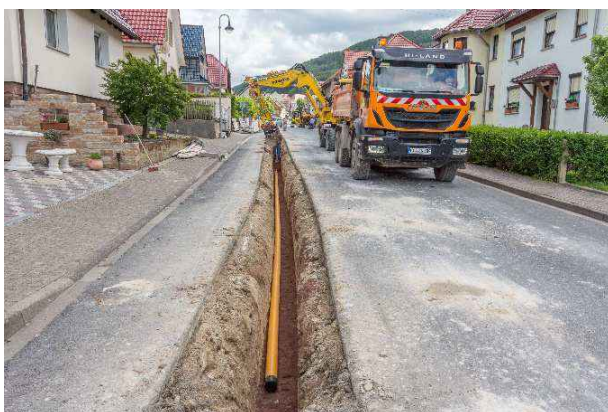
Erdgastechnische Erschließung der Gemeinde Lutter
