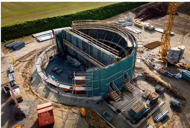
Neubau eines Hochbehälters in Kalteneber
