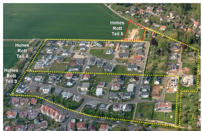
Fertigstellung der Erschließung „Auf dem Hohen Rott – Teil 5“ in Heilbad Heiligenstadt im Dezember 2021
