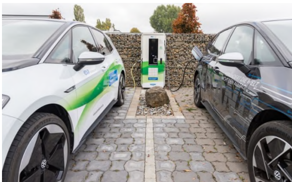
Ausbau Ladeinfrastruktur – Inbetriebnahme Ladesäule in Dingelstädt (Autohaus Iffland) im November 2021
