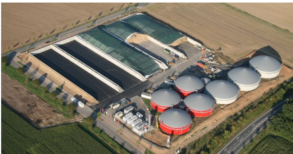
Die Biogasanlage der EAM Natur Energie GmbH in Hardegsen (Landkreis Northeim).
