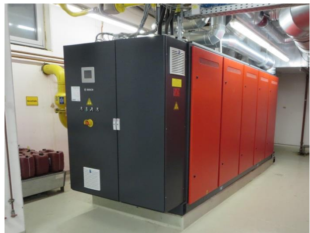
Erneuerung BHKW im Vitalpark in Heilbad Heiligenstadt
