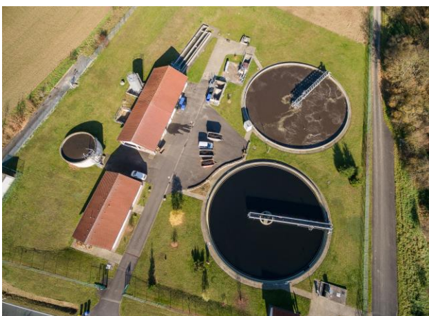
Erweiterung Kläranlage Horsmar
