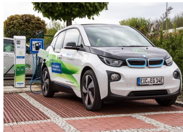
Ladesäule Verwaltungsgebäude Worbis
