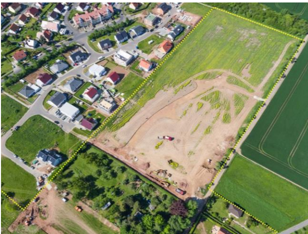
Erschließung Wohnbaugebiet „Auf dem Hohen Rott – Teil 4“
